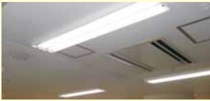
交換後のLED照明（老健所沢ロイヤルの丘） 外見上は既存の照明と大きな違いはありません
