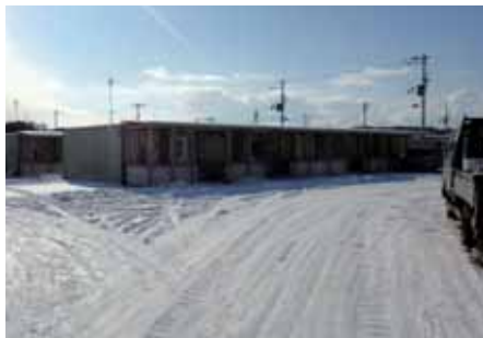
水道管も凍結するほどの厳しい寒さの仮設住宅
